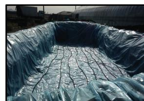
[그림 8] 저압분산 고무질호스(유니바이오허스) 설치 모식도 및 설치방법
