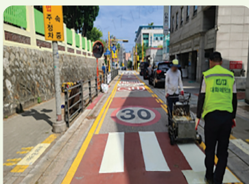
횡단보도 및 안전시설 재도색
