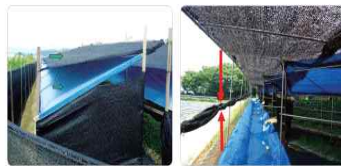
(고온기 후기 2중차 차광막 설치)
