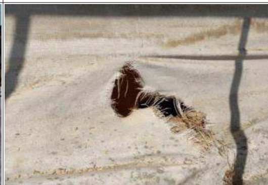
축사 구멍(찢어진 부위)
