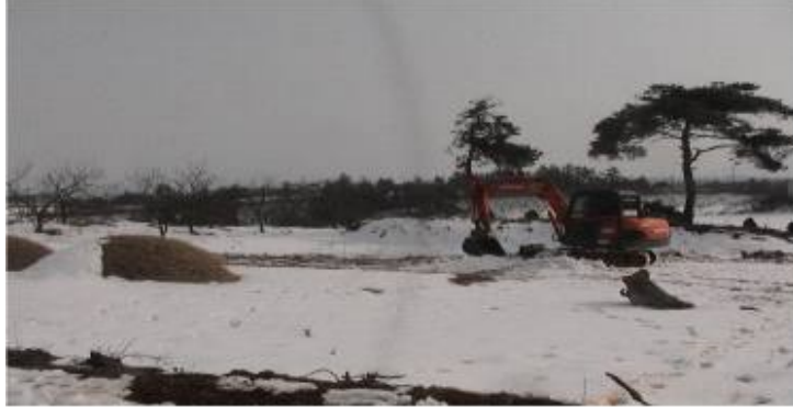
살처분 저장조 시설전 토목평탄작업
